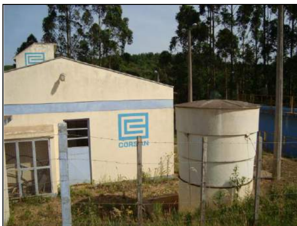
FOTO 03 – Estação de Tratamento
