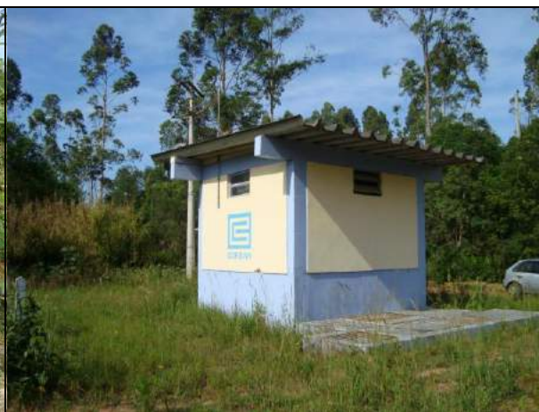
FOTO 02 – Est. Elevatória/Água Bruta
