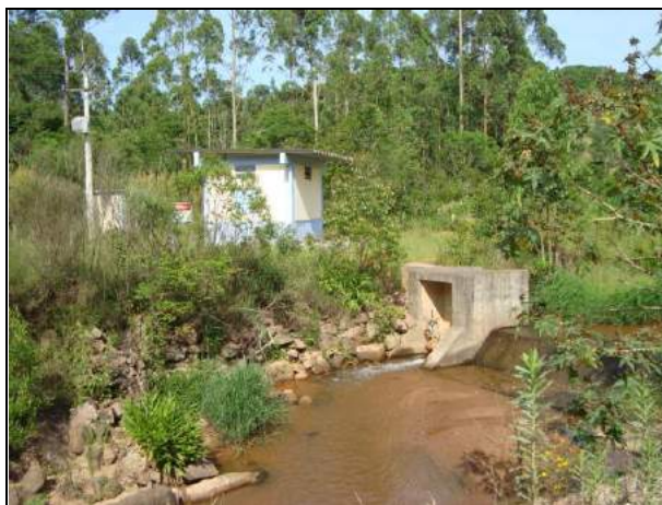
FOTO 01 – Captação da Água
