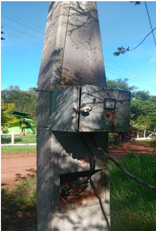
Foto 09: Manutenção de caixa de comando Linha Marçal
