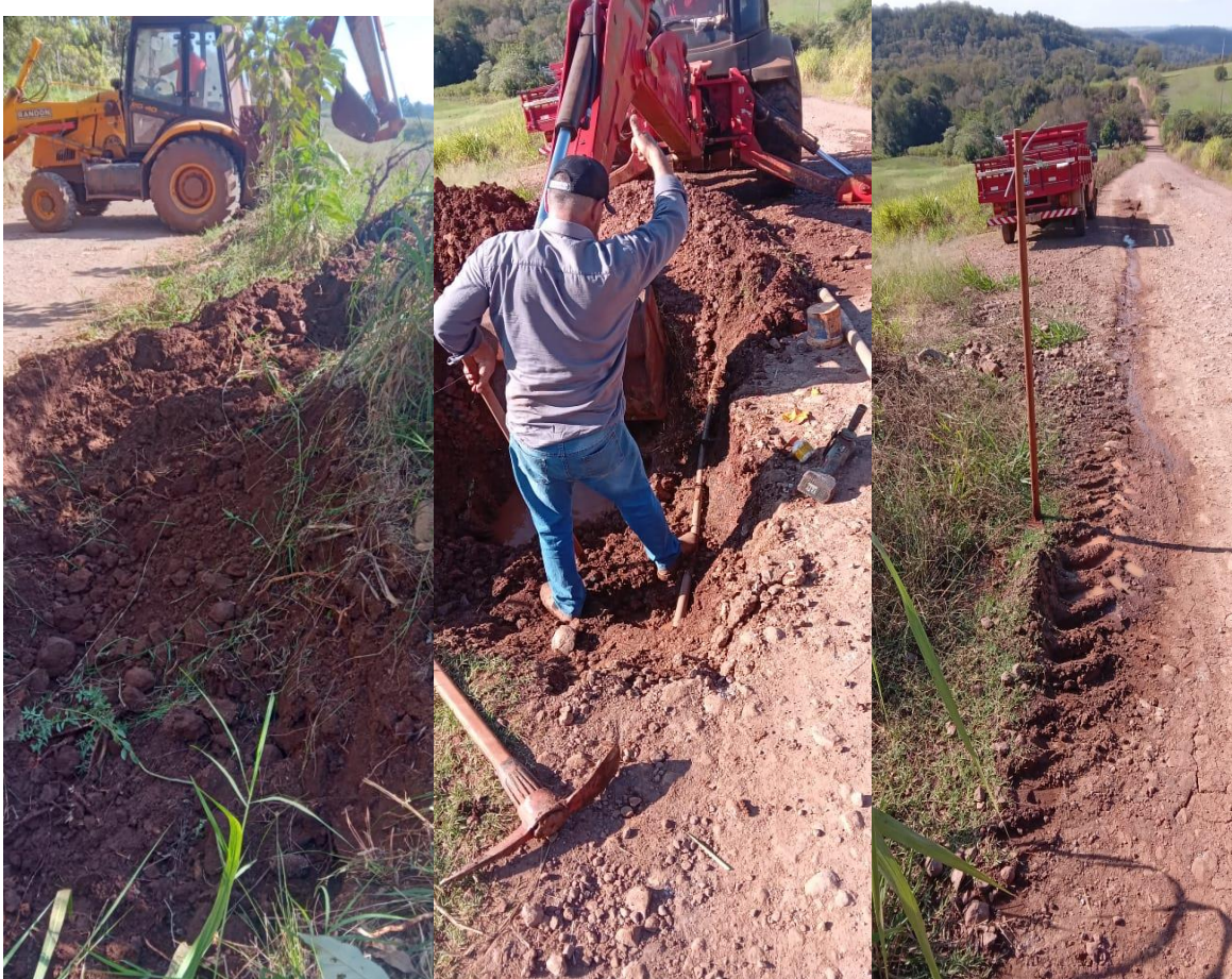
Foto 26,27 e 28 Conserto da rede de água Linha Manica
