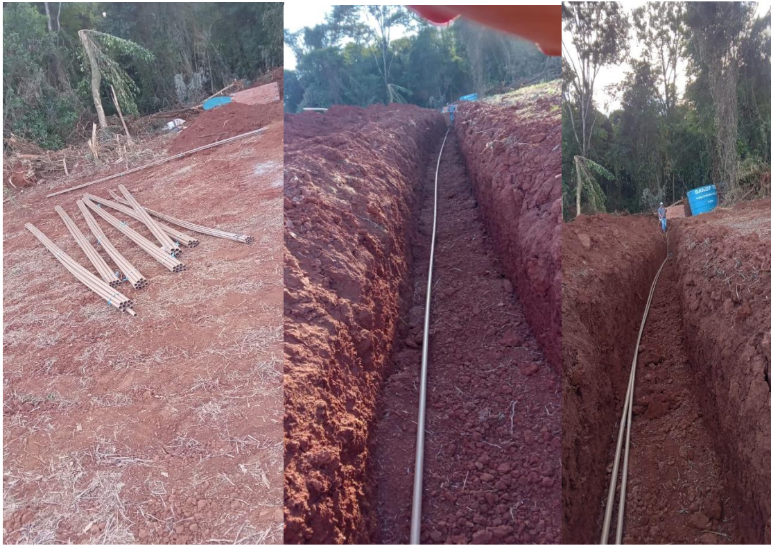
Foto 17,18 e 19 ampliação de rede de agua Sitio Ienerich
