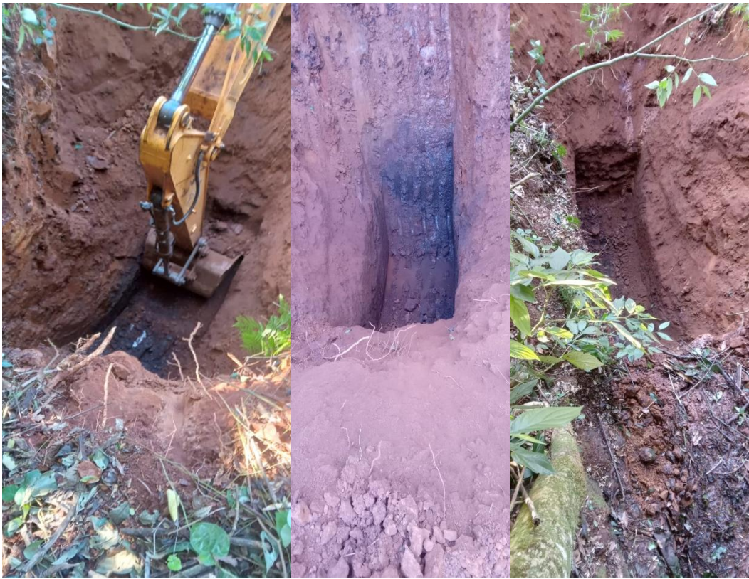
Foto 21,22 e 23 Limpeza de uma fonte de água linha vista alegre
