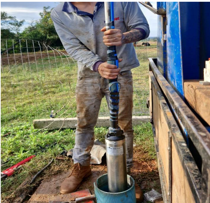
Foto 20 Troca da bomba de água poço linha João Batista Prates
